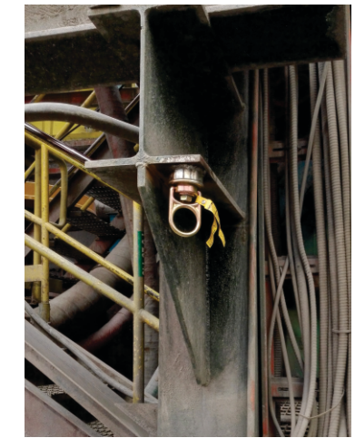
INSTALACIÓN DE PUNTOS ANCLAJE E IZAJE - UM ATACOCHA Y EL PORVENIR
