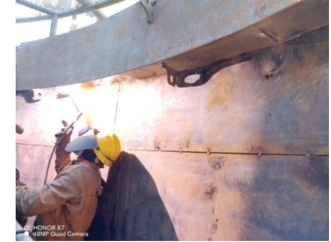
REPARACION DE TANQUE ESPESADOR DE CU 30X10 PLANTA VICTORIA UM CARAHUACRA
