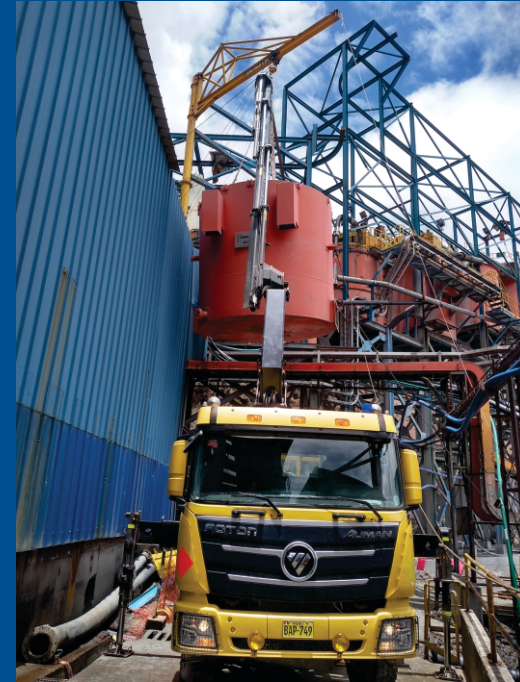
MONTAJE DE CELDA RCS 30 UM CHUNGAR
