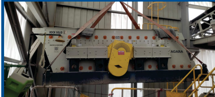
MONTAJE DE ZARANDA TYCAN UM ALPAMARCA
