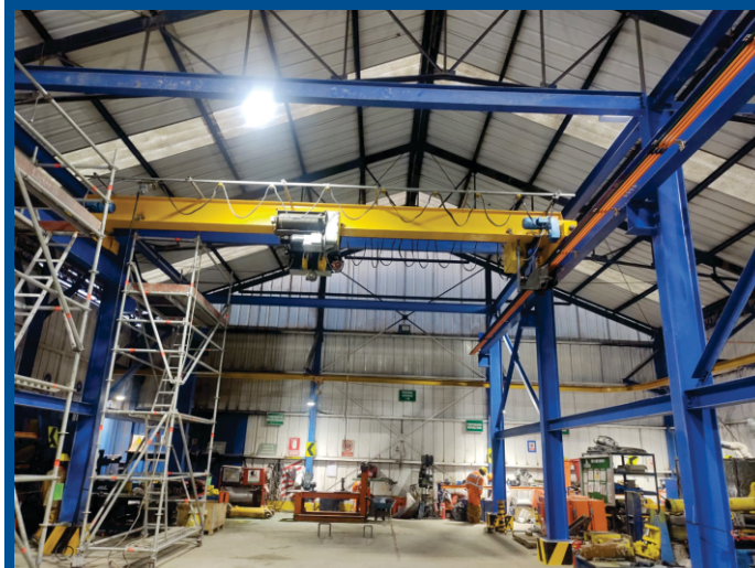
MONTAJE DE PUENTE GRUA 10 TN TALLER CRC - UM CHUNGAR
