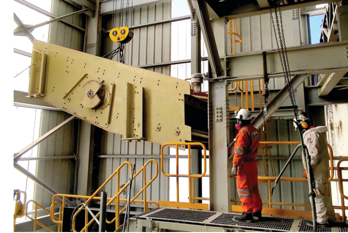
MONTAJE DE ZARANDA METSO 6X16 UM ALPAMARCA
