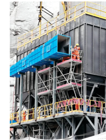
MONTAJE DE COLECTOR DE POLVO UM ATACOCHA
